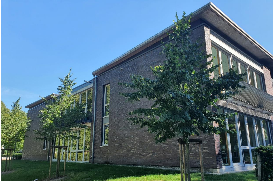
Abbildung 18 Nordfassade des Atriums
