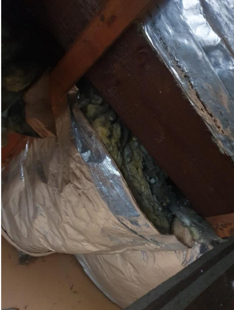
Abbildung 21: beschädigte Zwischensparrendämmung
