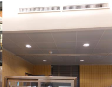
Abbildung 7 Lüftung Essensausgabe
