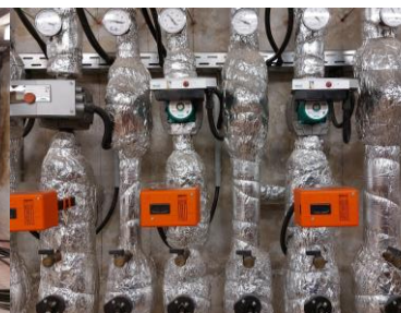
Abbildung 13 Heizungsverteilung
