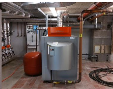
Abbildung 12 Gas-Brennwertkessel
