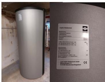
Abbildung 11 Warmwasserspeicher
