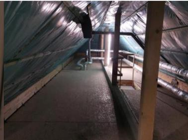
Abbildung 10 Dachflächen gedämmt
