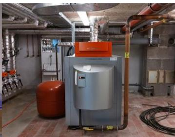
Abbildung 12 Gas-Brennwertkessel
