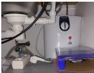
Abbildung 11 Elektro-Warmwasserspeicher
