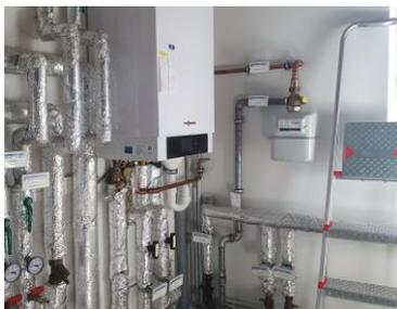
Abbildung 11 Gas-Brennwertkessel
