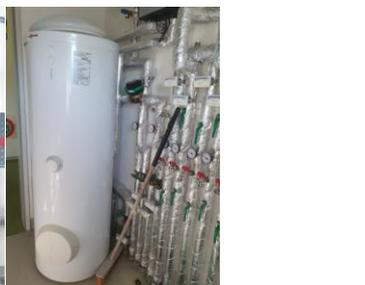
Abbildung 12 Warmwasserspeicher
