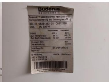
Abbildung 13 Typenschild Warmwasserspeicher
