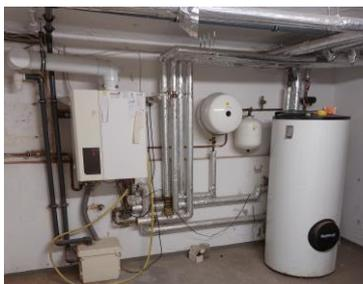
Abbildung 11 Heizungsanlage mit Warmwasserbereitung
