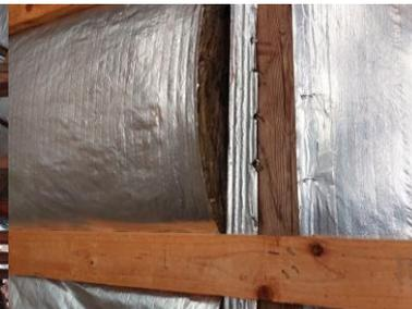
Abbildung 10 Zwischensparrendämmung
