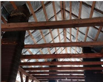
Abbildung 9 Dachraum, gedämmt
