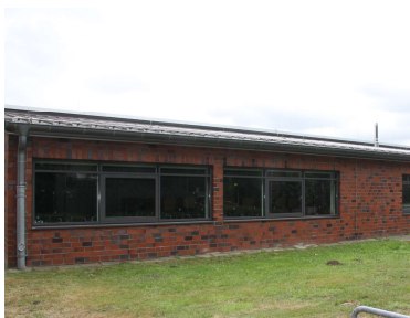
Abbildung 2 Außenansicht Nordwestfassade Baulabor
