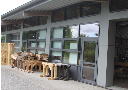
Abbildung 31 Zweifach verglaste Fensterfassade von Bauhallen
