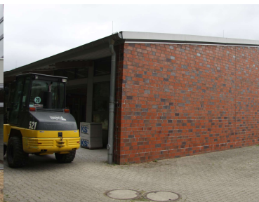
Abbildung 6 Außenansicht Nordostfassade Bauhallen
