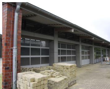
Abbildung 4 Außenansicht Südostfassade Bauhallen
