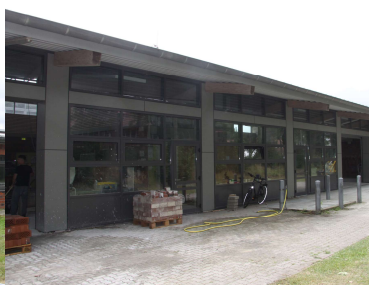
Abbildung 3 Außenansicht, Nordwestfassade Bauhallen
