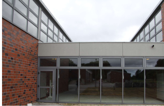
Abbildung 32 Zweifach verglaste Fensterfassade von Eingangshalle und Oberlichter
