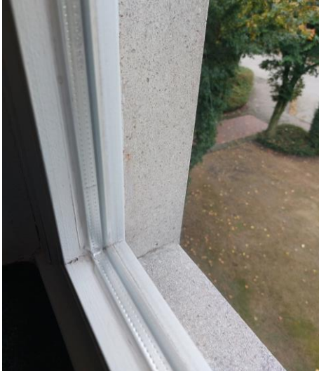
Abbildung 38 Zweifach verglastes Fenster mit Holzrahmen
