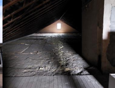
Abbildung 4 Dachgeschoss nicht ausgebaut, OGD gedämmt
