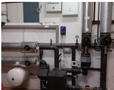
Abbildung 11 Wärmeübergabestation
