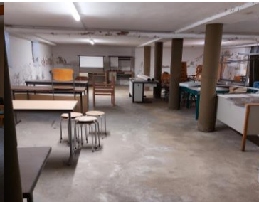
Abbildung 9 Keller nördlicher Bauteil
