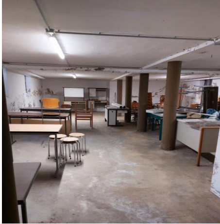
Abbildung 30 Kellerdecke ungedämmt
