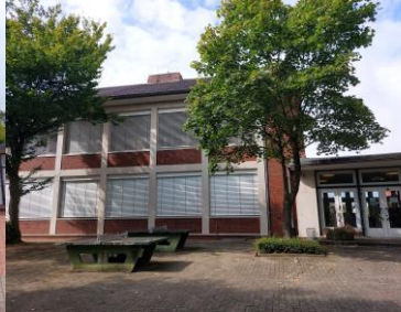
Abbildung 3 Außenansicht, Blickrichtung Osten
