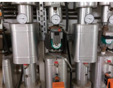
Abbildung 13 Heizungspumpe
