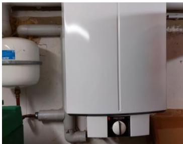
Abbildung 12 Elektro-Warmwasserspeicher
