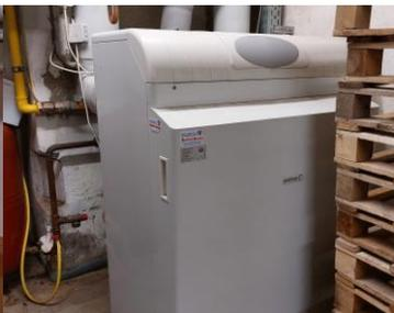
Abbildung 13 Erdgas-Brennwertkessel
