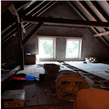
Abbildung 28 Oberste Geschossdecke Haus 1, ungedämmt
