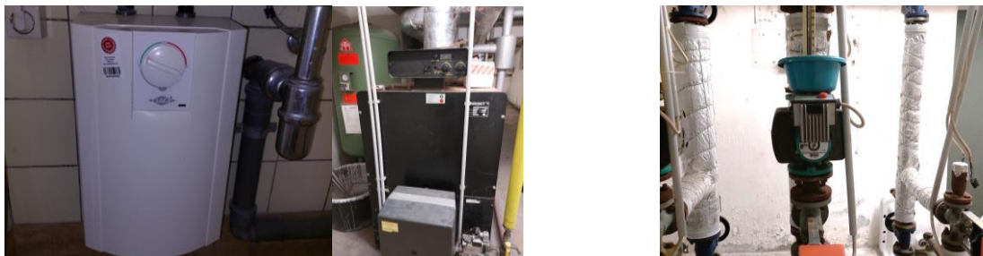
Abbildung 11 Elektro-Warmwasserspeicher Sanitärraum
