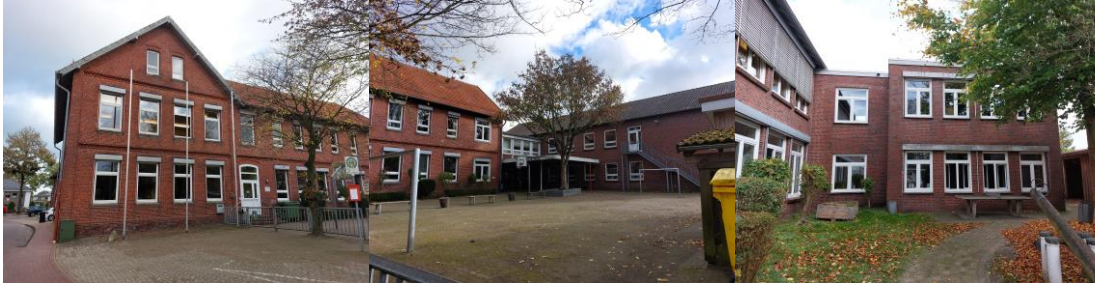
Abbildung 2 Außenansicht, Blickrichtung Nordosten
