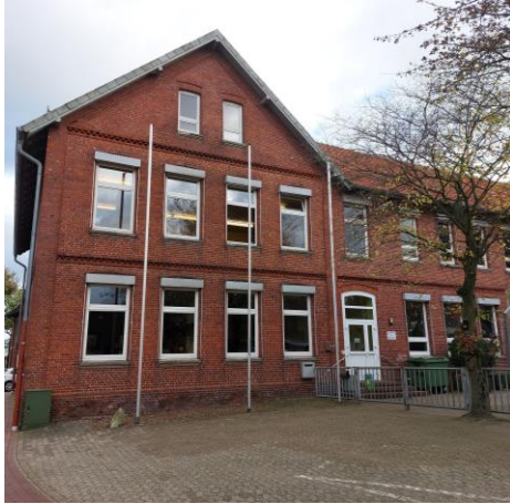
Abbildung 42 Außenansicht Soeste Schule
