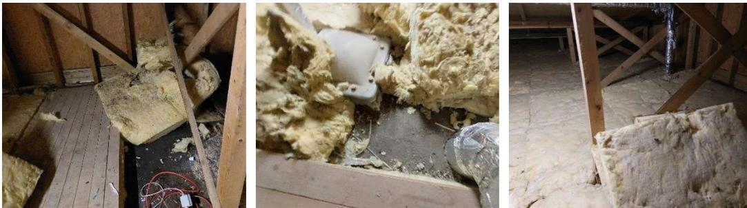
Abbildung 9 Offene Stellen der OGD-Dämmung
